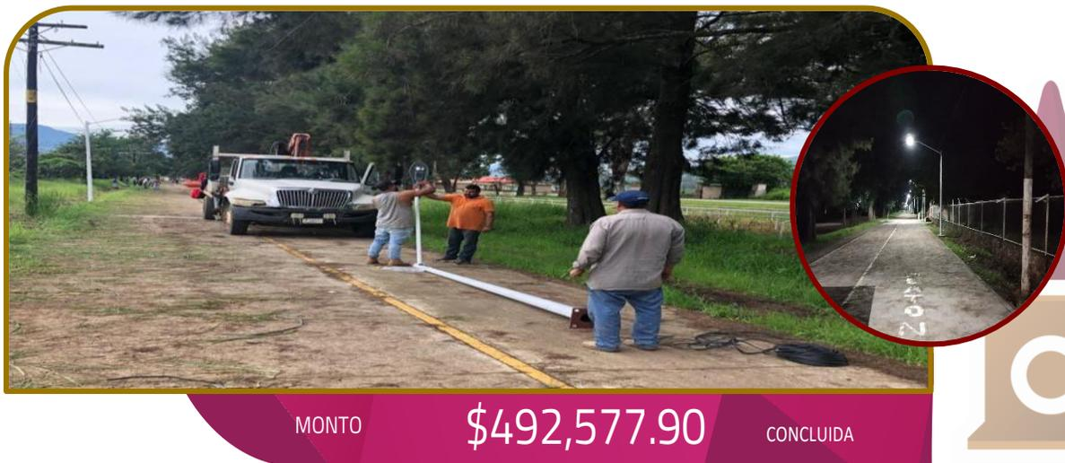
Se realizó la colocación de luminarias con instalación eléctrica oculta, y postes de 6.00 mts.
